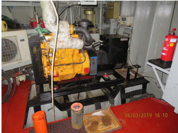
Generatorset voorschip
